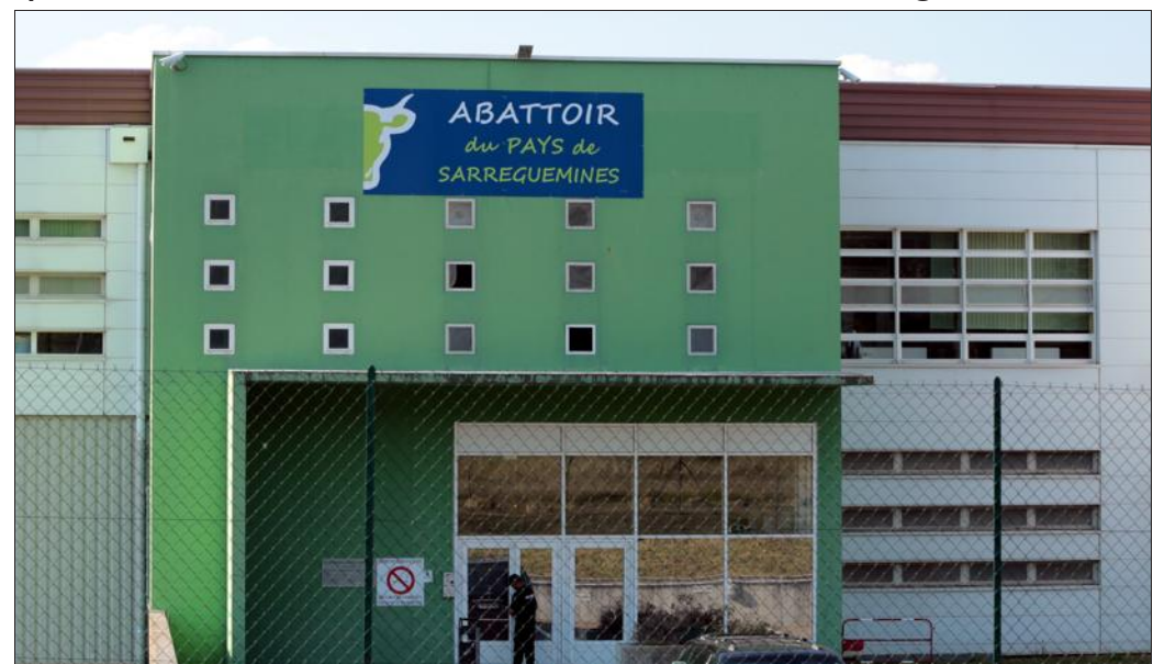
Pour sauver cet équipement ultramoderne, la Casc avait racheté l'ensemble des biens mobiliers et immobiliers et créé une société publique locale qui a permis de relancer l'activité. Photo RL.
